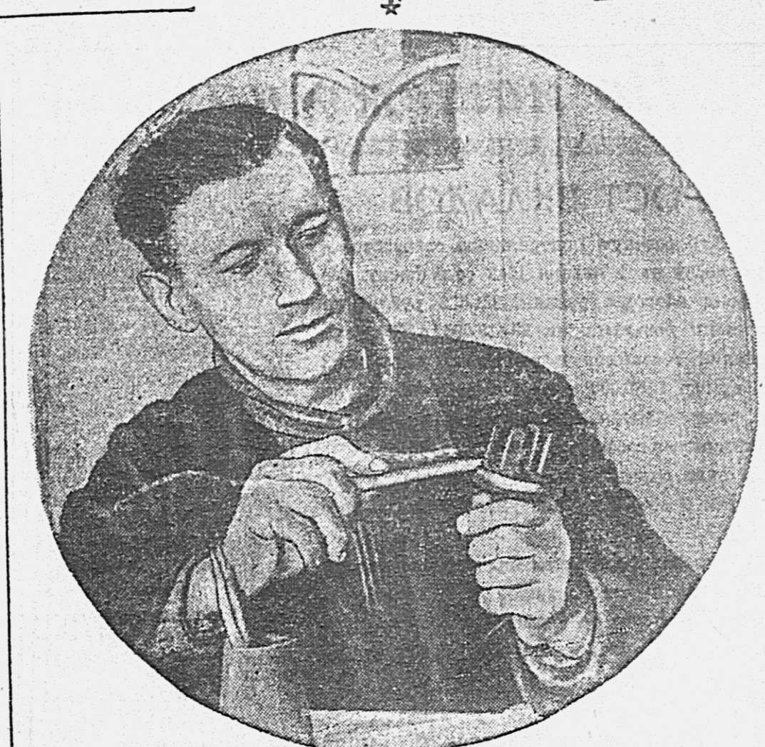
Начальник отдела технического контроля Благовещенского завода «Амурский металлист» А. П. Любченко сдает ценные рационализаторские предложения, позволяющие изготовлять илапаны на паровых котлах не из бронзы, а из черных металлов. На снимке: тов. Любченко осматривает илапан после испытаний.
