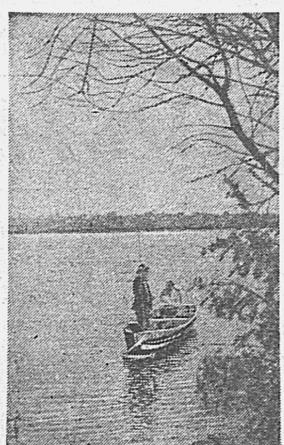
Водный режим р. Тунгуски систематически изучается Кур-Урмийской гидрогеологической станцией. В 1940 году определено 30 измерений расхода воды, охвачена вся амплитуда уровней. На снимке: за определенным расходом воды техник гидролог тов. Скляров. Фото А. Цыганкова.
