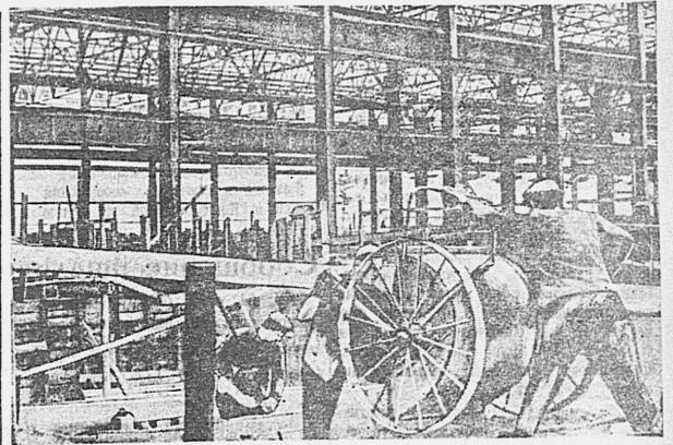
Бетонирование фундаментов подстанции листопрокатного цеха завода Амур-сталль. На снимке: заливка фундамента тов. Фото В. Григорьева.
