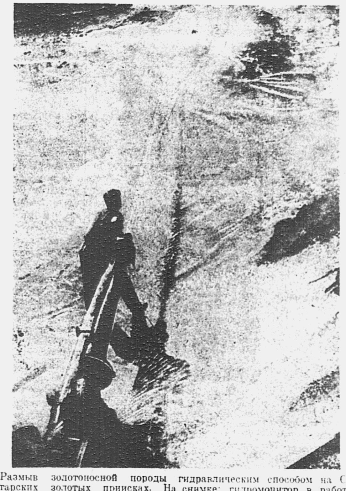
Разрыв золотистой породы гидравлическим способом на Старых золотых приисках. На снимке: гидромонитор в работе. Фото В. Байдалова.
