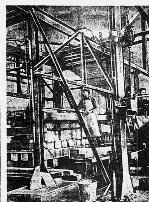
Раньше распиловка мраморных блоков в артиле «Биробиджанский мрамор» производилась ручным способом. Сейчас здесь установлены пилорамы по 30 пил в каждой. Пилорама обслуживается одним рабочим и может распиливать одновременно 48 мраморных блоков. На снимке: распиловка мрамора. Фото С. Образцова. (Фотохроника КрайТАСС).
