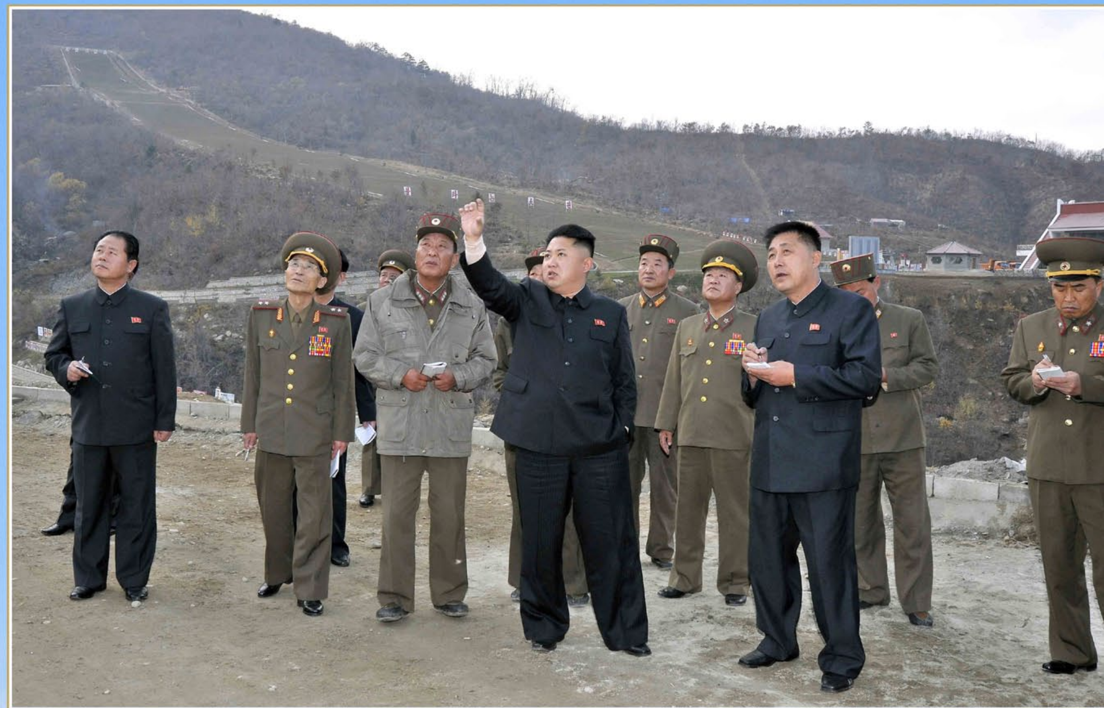
На стройке Масикрёнского горнолыжного комплекса. Ноябрь 2013 г.
