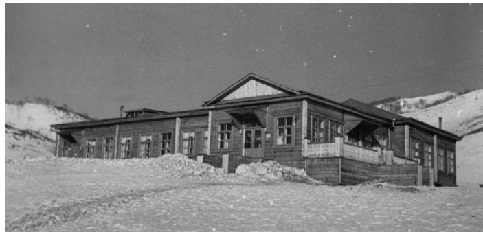
Строительство больницы в посёлке Индустриальном, 1936 год.
