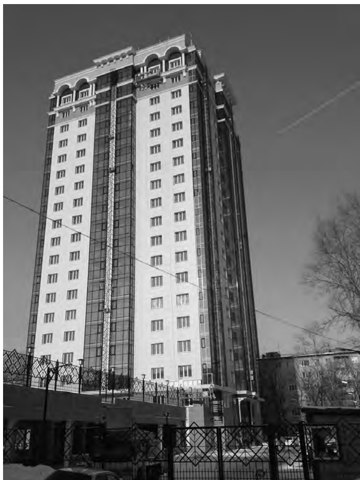
Строящийся микро-небоскрёб на ул. Владивостокской (г. Хабаровск) с аркатурой и профилированным карнизом, венчающим здание.
