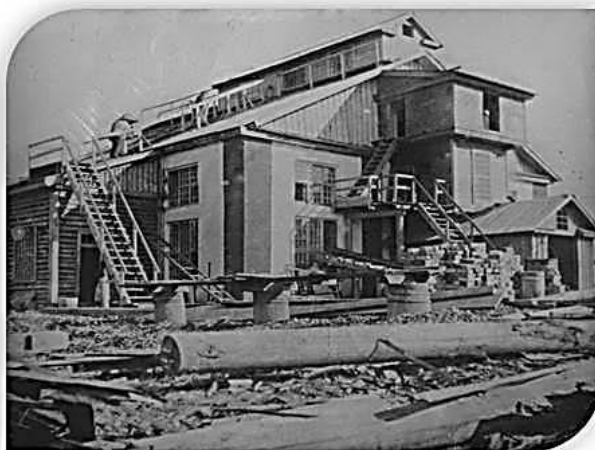
Строительство Радиового завода в Бондюжах (Патарстан)
